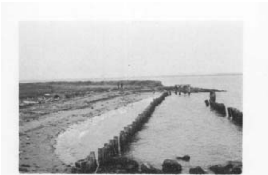
Fig. 4 - Argine nord-est della «Cassa B» con protezione a palificate.
