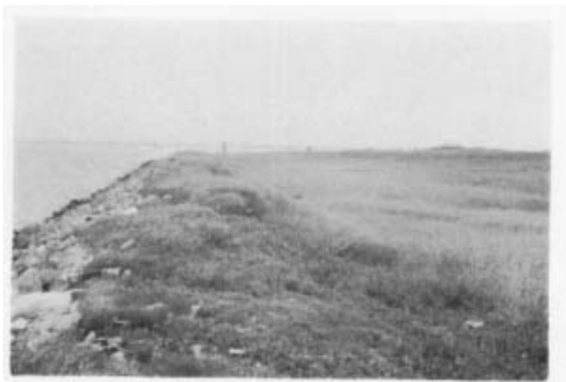
Fig. 5 - Argine orientale a massicciata. Si può notare una distesa a Calamagrostis epigeios Roth.
