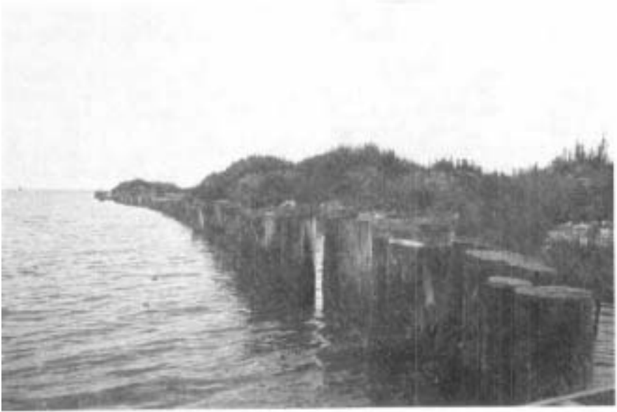
Fig. 7. Lato settentrionale: è visibile l'arginatura originaria della cassa.
